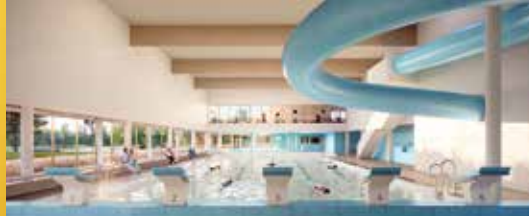
Spade in de grond voor nieuw zwembad (p. 2)
